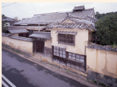
保存修理工事前の三木家住宅
