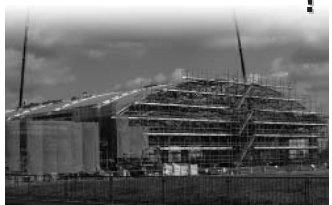
順調に工事が進む多目的ドーム
