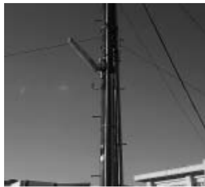
電柱に共架された防犯灯
