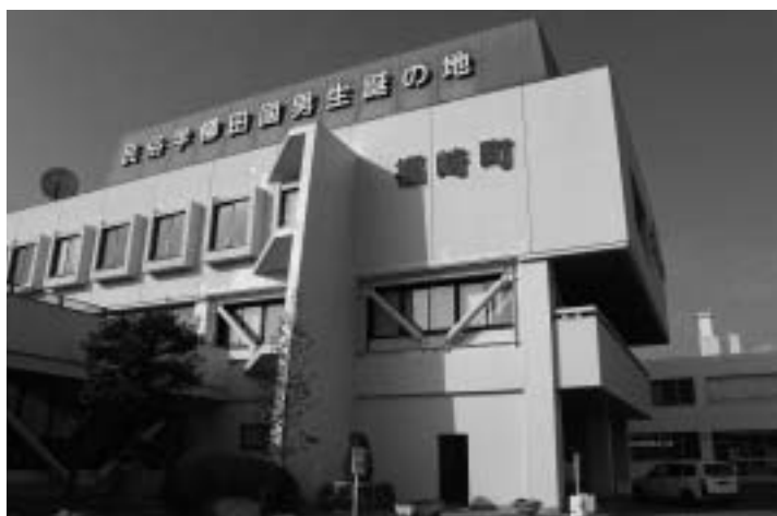
バトレスや鉄骨ブレースが設置され、耐震強度が向上しました。
