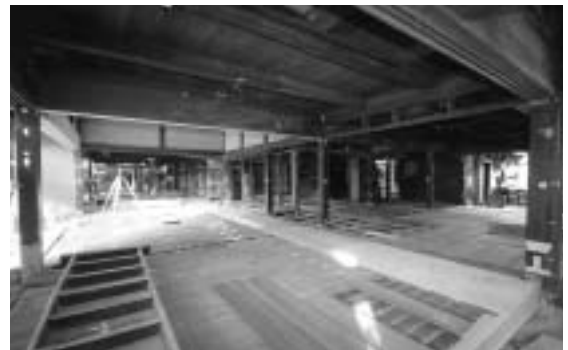
内装工事がすすむ主屋内部
