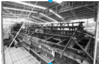
垂木を撤去 小屋組のようす
