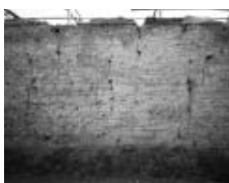
北土塀 型枠を固定する部材を通した穴
