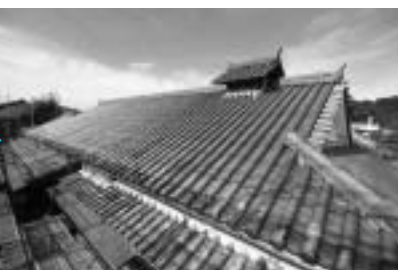
屋根修理完了！
