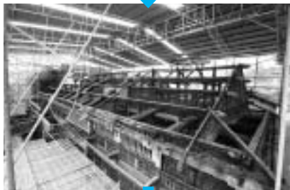
垂木を撤去 小屋組のようす
