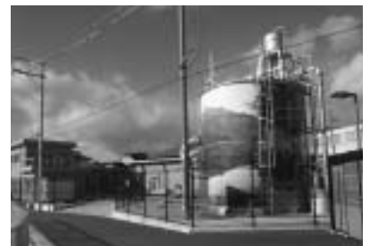
福田水源地全景
