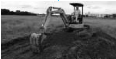
機械掘削 重機を使って地面を掘り下げて、遺跡の有無を確認。
