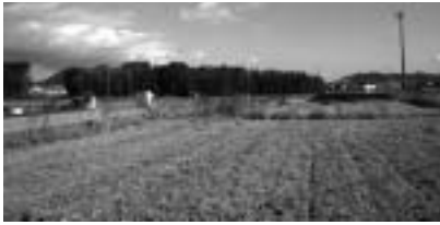
試掘坑の設定 調査地の状況を確認し、試掘坑(2m×2m)の位置を決定。
